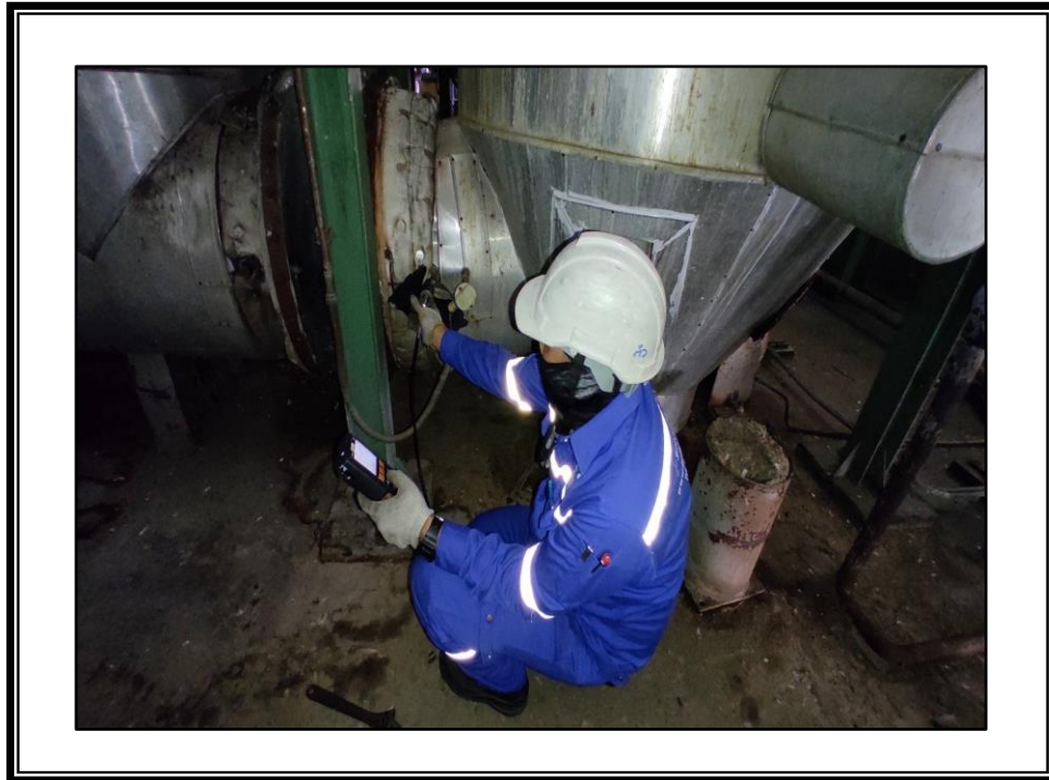
รูปที่ 3.2-1 จุดตรวจวัดคุณภาพอากาศจากปล่องปล่อยทิ้งอากาศเสีย บริเวณปล่อง Waste Heat Boiler ที่ต่อกับเครื่องยนต์ Caterpillar No.5 ในวันที่ 3 ตุลาคม พ.ศ. 2566
