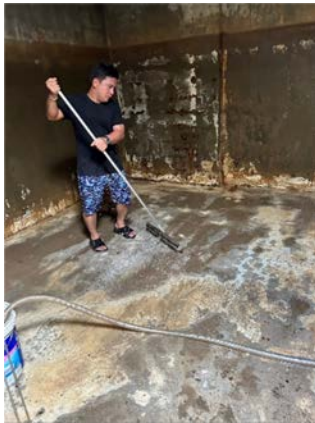
รูปที่ 2-19 การล้างทำความสะอาดถังเก็บน้ำสำรอง
