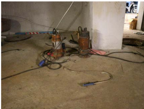
รูปที่ 2-14 อุปกรณ์สำรองระบบบำบัดน้ำเสีย
