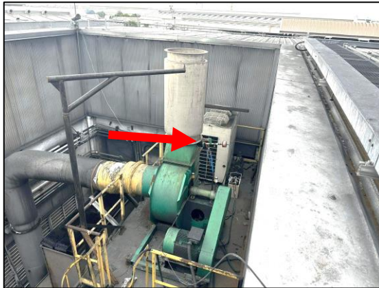
รูปที่ 3.1 การเก็บตัวอย่างคุณภาพอากาศในปล่องระบาย บริเวณ ปล่อง Wet Scrubber No.2 (เฉพาะหน่วยหลอมทองแดงเท่านั้น)
