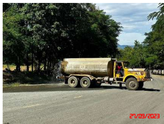
รูปที่ 5 การฉีดพรมน้ำภายในพื้นที่โครงการ
