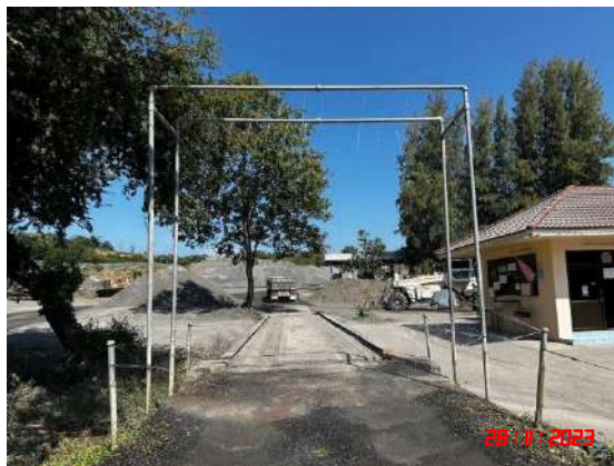
รูปที่ 31 จุดสเปรย์น้ำล้างล้อรถบรรทุก
