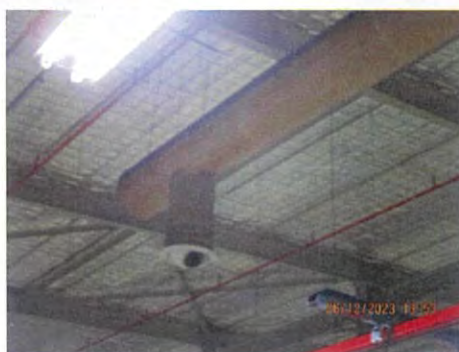
ภาพที่ 2.2-41 ระบบทำความเย็น เพื่อควบคุมอุณหภูมิในบริเวณพื้นที่ทำงาน
