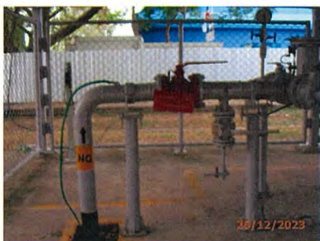
ภาพที่ 2.2-54 ข้อความแสดงทิศทางการหมุนวาล์วและข้อความแสดงทิศทางการไหลในท่อขนส่งก๊าซธรรมชาติ
