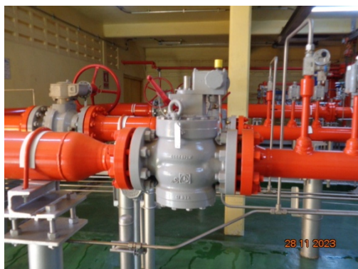
รูปที่ 3-5 วาล์วควบคุมแรงดันเกิน (Safety Shut Off Valve) บริเวณสถานีก๊าซฯ OTS
