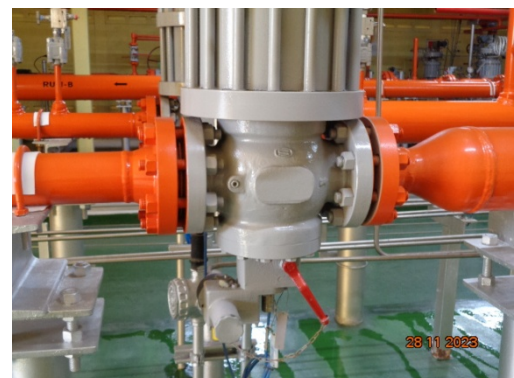
รูปที่ 3-5 วาล์วควบคุมแรงดันเกิน (Safety Shut Off Valve) บริเวณสถานีก๊าซฯ OTS
