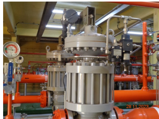
รูปที่ 3-7 วาล์วควบคุมแรงดันก๊าซ (Pressure Control Valve) บริเวณสถานีก๊าซฯ OTS
