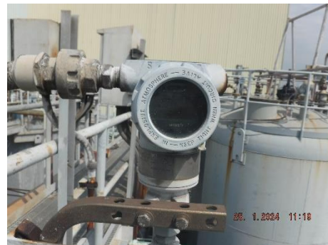
ภาพที่ 2.2-26 การติดตั้ง Pressure Gauge บริเวณถังเก็บของเสีย
