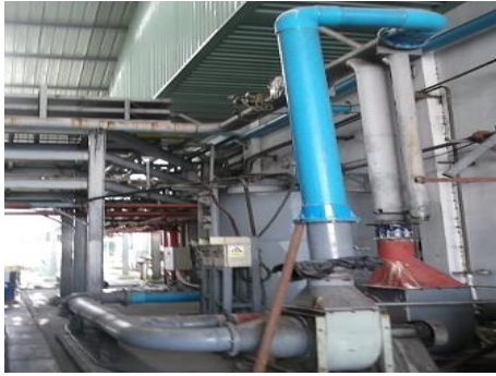
ภาพที่ 2.2-4 ระบบบำบัดกลิ่นภายในห้องสูบล้าง ของเสียที่เป็นของเหลวและระบบบำบัดอากาศ กรณีเผาเกิดขัดข้อง
