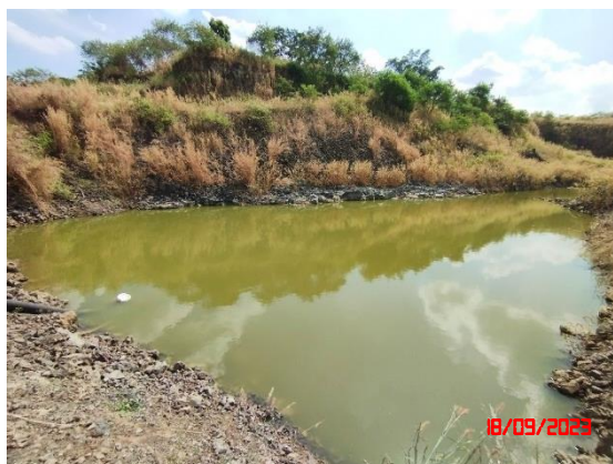
รูปที่ 24 บ่อรองรับน้ำบริเวณหน้าเหมืองในจุดต่ำสุด (Sump)
