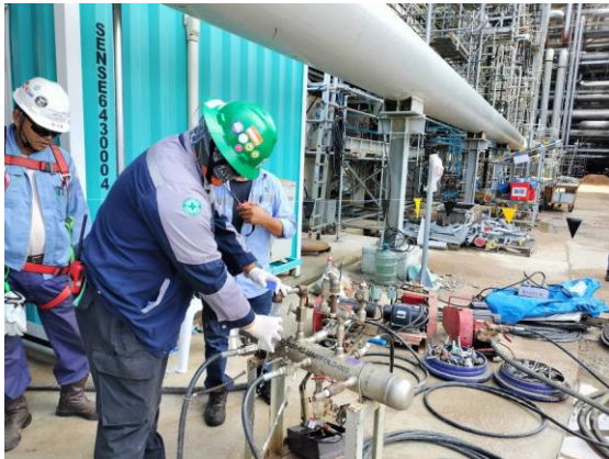
รูปที่ 2-14 การทดสอบแรงดันของท่อ (Hydrostatic Test)
