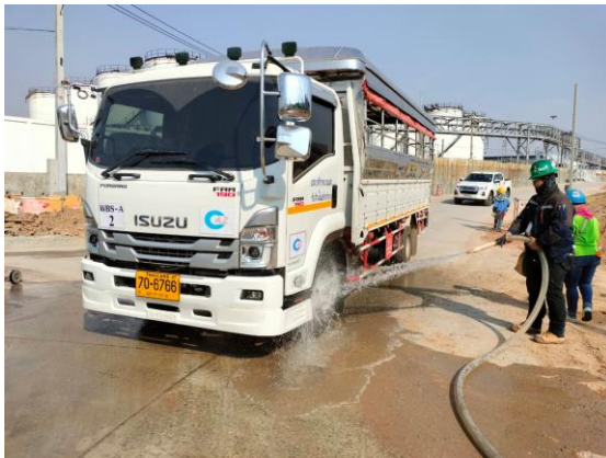
รูปที่ 2-5 การล้างล้อรถบรรทุก
