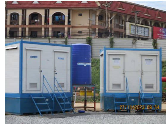
รูปที่ 2-8 ห้องน้ำ ห้องส้วม พร้อมระบบบำบัดน้ำเสียสำเร็จรูปแบบเคลื่อนที่
