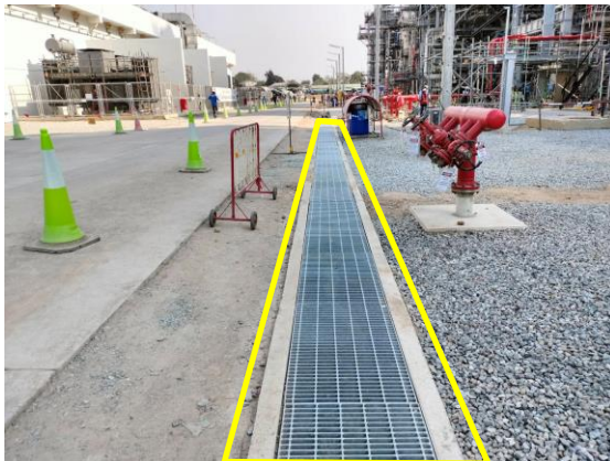
รูปที่ 2-9 ระบบระบายน้ำในพื้นที่ก่อสร้างและเชื่อมต่อกับบ่อรวบรวม
