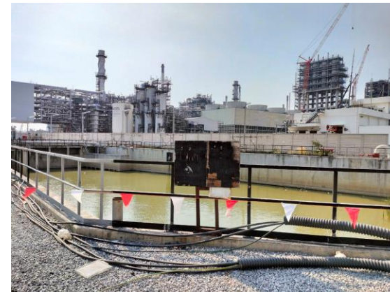
รูปที่ 2-9 ระบบระบายน้ำในพื้นที่ก่อสร้างและเชื่อมต่อกับบ่อรวบรวม
