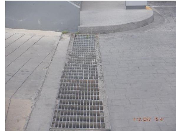
รูปที่ 2-18 ติดตั้งตะแกรงดักมูลฝอยบริเวณจุดระบายน้ำเข้าสู่ท่อระบายน้ำ
