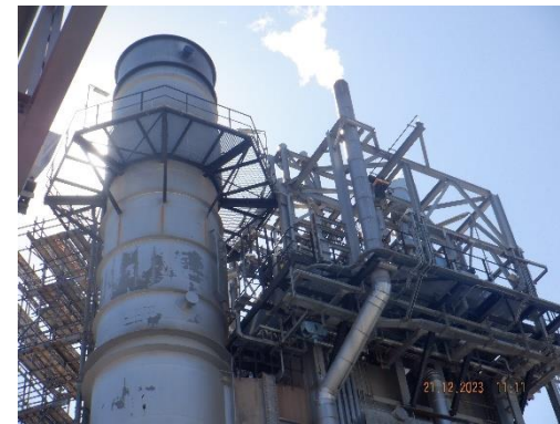
รูปที่ 2-7 โครงการติดตั้ง Silencers จำนวน 5 แห่ง
