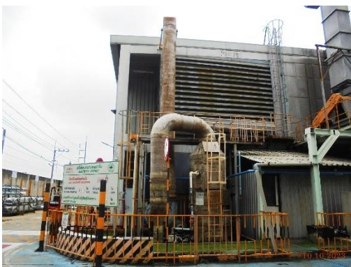
Cyclone อนุกรมกับ Bag Filter
