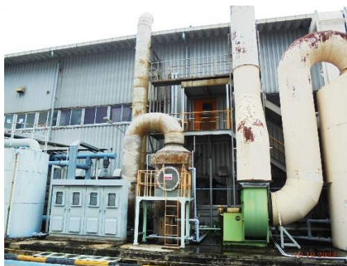
Cyclone อนุกรมกับ Bag Filter
