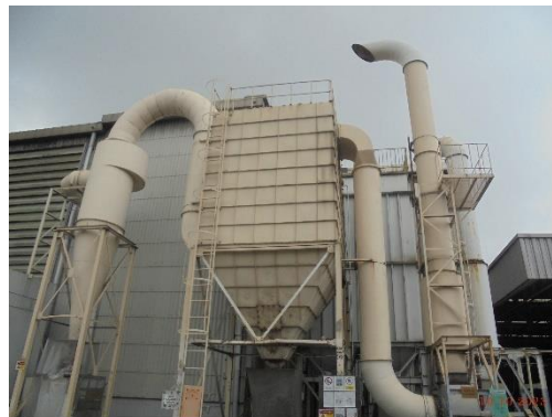
Cyclone อนุกรมกับ Bag Filter
