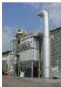
Dust Collector No.3 (บำบัดอากาศจาก Hood หน้าเตาหลอม)
