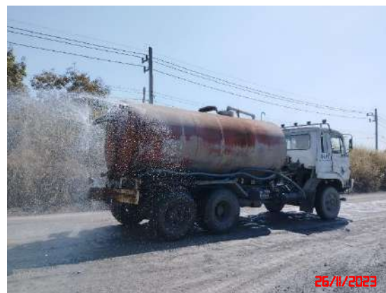
รูปที่ 15 การฉีดพรมน้ำเพื่อลดผลกระทบด้านการฟุ้งกระจายของฝุ่นละออง
