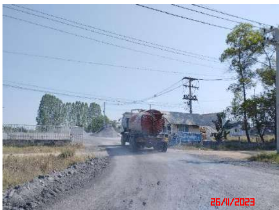
รูปที่ 15 การฉีดพรมน้ำเพื่อลดผลกระทบด้านการฟุ้งกระจายของฝุ่นละออง
