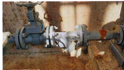
ภาพที่ 2.2-8 ตะแกรงดักตะกอนดิน ทราย และเศษขยะ ก่อนระบายน้ำทิ้งเข้าสู่บ่อพักน้ำ
