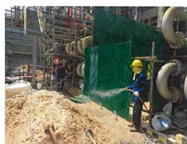
ภาพที่ 2.2-2 การฉีดพรมน้ำบริเวณพื้นที่ก่อสร้าง
