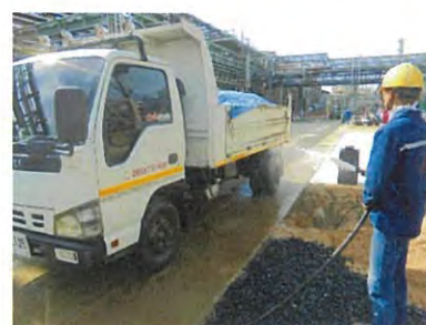
ภาพที่ 2.2-3 การทำความสะอาดล้อรถบรรทุกที่ออกจากพื้นที่ก่อสร้าง
