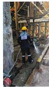
ภาพที่ 2.2-7 การดูแลทำความสะอาดรางระบายน้ำ/การเก็บกวาดเศษวัสดุที่อาจตกหล่น หรือถูกน้ำฝนชะพาลงสู่รางระบายน้ำ
