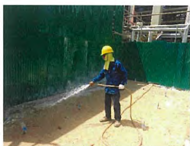
ภาพที่ 2.2-2 การฉีดพรมน้ำบริเวณพื้นที่ก่อสร้าง
