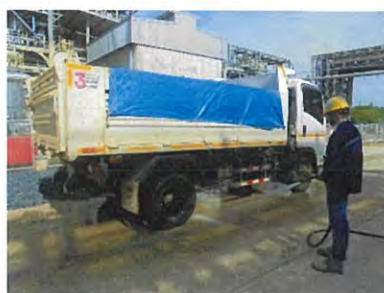
ภาพที่ 2.2-3 การทำความสะอาดล้อรถบรรทุกที่ออกจากพื้นที่ก่อสร้าง
