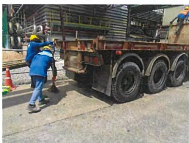
ภาพที่ 2.2-3 การทำความสะอาดล้อรถบรรทุกที่ออกจากพื้นที่ก่อสร้าง
