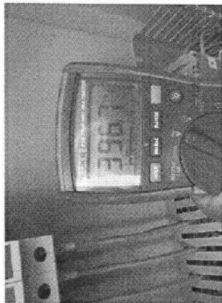
รูปที่ 30 แรงดันไฟฟ้าเฟส RT. ที่อ่านค่าได้เท่ากับ 396.7 Volt.
