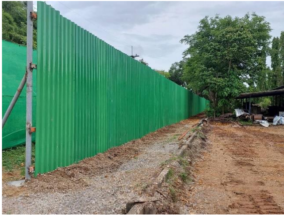
รูปที่ ข.1-10 กำแพงกันเสียงที่ทำจากแผ่นเหล็ก (Steel Sheet)
