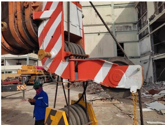
รูปที่ ข.1-43 การตรวจสอบอุปกรณ์การยกก่อนการใช้งาน
