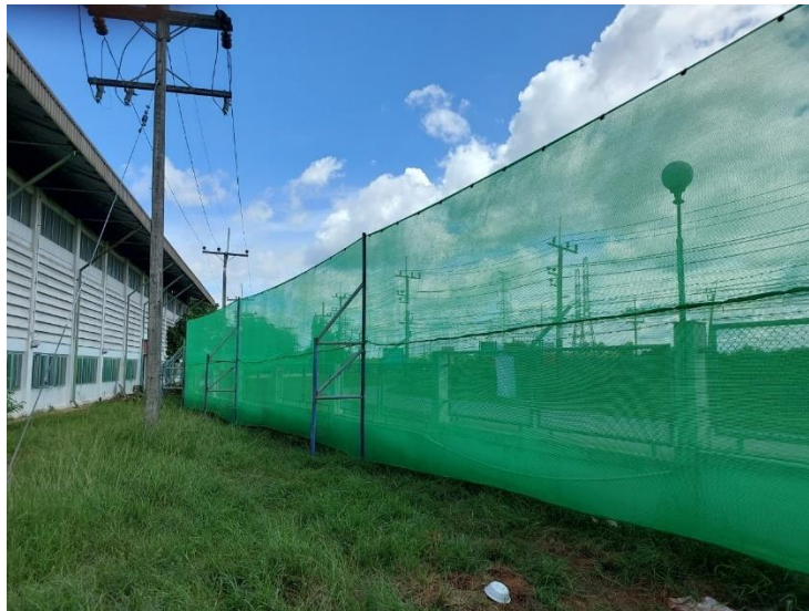
รูปที่ ข.1-3 การใช้วัสดุกันฝุ่นโดยรอบอาคาร
