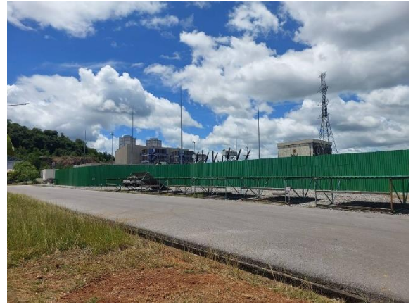
รูปที่ ข.1-10 กำแพงกันเสียงที่ทำจากแผ่นเหล็ก (Steel Sheet)
