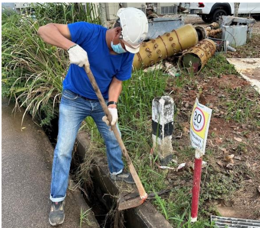
รูปที่ ข.1-27 การตรวจสอบและขุดลอกรางระบายน้ำ
