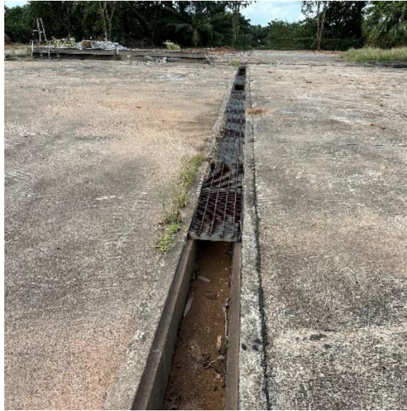
รูปที่ ข.1-26 รางระบายน้ำเดิมของโครงการ
