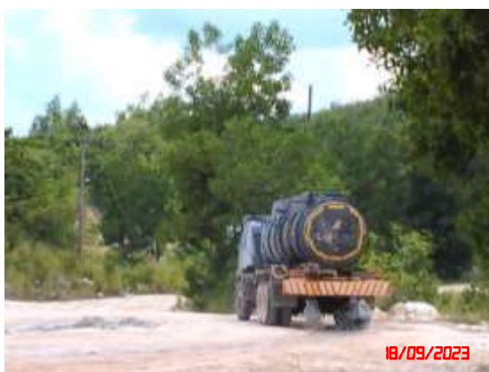
รูปที่ 11 การฉีดพรมน้ำบริเวณพื้นที่โครงการ
