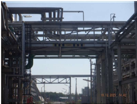
รูปที่ 2-39 การวางท่อบน Pipe Rack หรือ Pipe Bridge ในลักษณะที่ปลอดภัย
