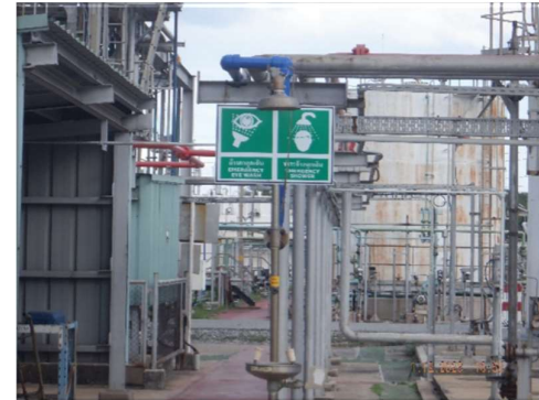
รูปที่ 2-28 ผักบัวอาบน้ำ ล้างตา จุกเงิน
