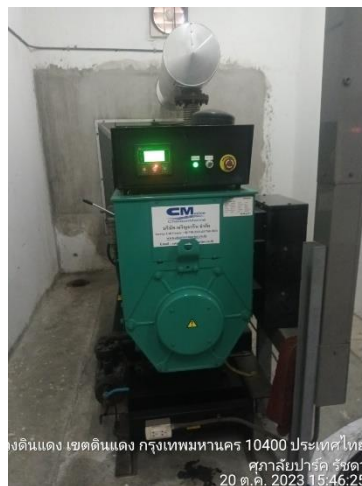
รูปที่ 14 เครื่องกำเนิดไฟฟ้าสำรอง
