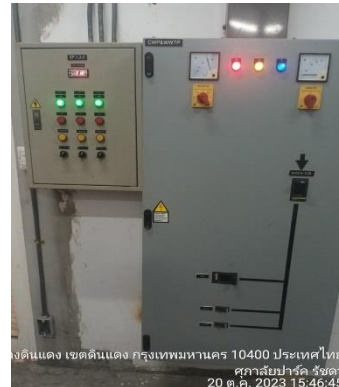
รูปที่ 29 ตู้ไฟฟ้าแรงต่ำ
