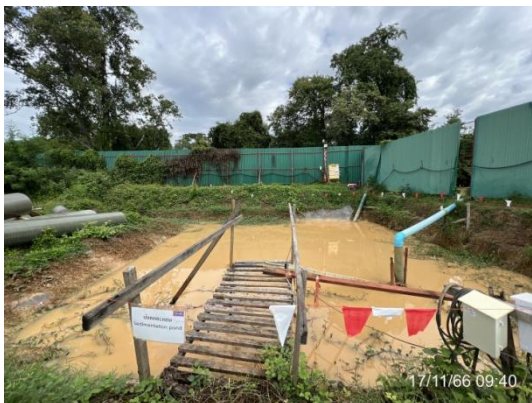
รูปที่ 3-28 บ่อดักตะกอนน้ำชั่วคราว ภายในพื้นที่โครงการ
