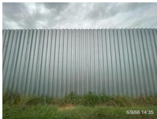
รูปที่ 3-13 กำแพงกันเสียงชั่วคราวบริเวณบ้านหลังโรงไฟฟ้า (ด้านทิศใต้ของโครงการ)
