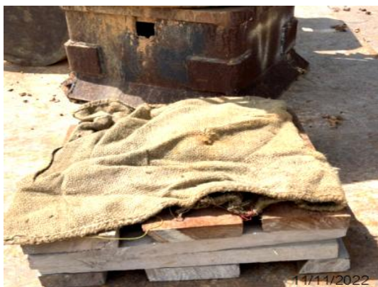
รูปที่ 3-14 ไม้หมอนและกระสอบรองหัวเสาเข็ม
