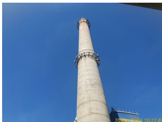
รูปถ่ายที่ 3.2-4 : ปล่องระบายอากาศเสียของหม้อไอน้ำ ขนาด 75 ตัน/ชั่วโมง
