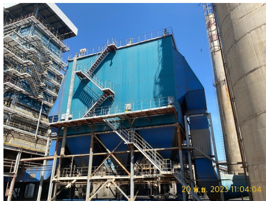
รูปถ่ายที่ 3.2-2 : ระบบดักฝุ่นละอองแบบไฟฟ้าสถิต (ESP) ของหม้อไอน้ำ ขนาด 75 ตัน/ชั่วโมง
