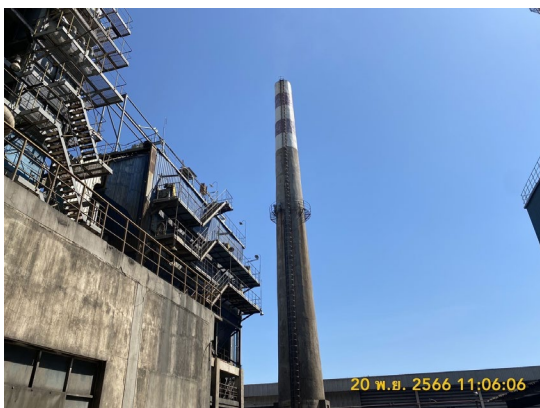
รูปถ่ายที่ 3.2-3 : ปล่องระบายอากาศเสียของหม้อไอน้ำ ขนาด 35 ตัน/ชั่วโมง
