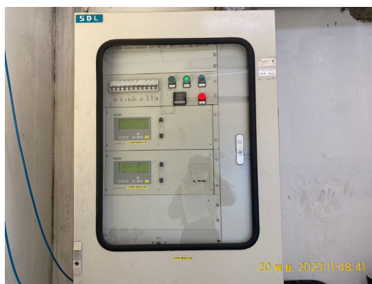
รูปถ่ายที่ 3.2-6 : ระบบตรวจวัดคุณภาพอากาศแบบต่อเนื่อง (CEMs) ปล่องระบายของหม้อไอน้ำขนาด 75 ตัน/ชม.
