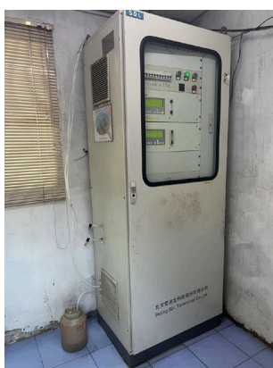
รูปถ่ายที่ 3.2-5 : ระบบตรวจวัดคุณภาพอากาศแบบต่อเนื่อง (CEMs) ปล่องระบายของหม้อไอน้ำขนาด 35 ตัน/ชม.
