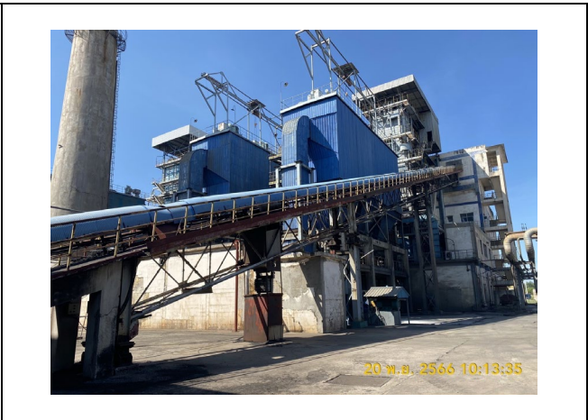
รูปถ่ายที่ 3.2-10 : ระบบสายพานลำเลียงถ่านหินระบบปิด
