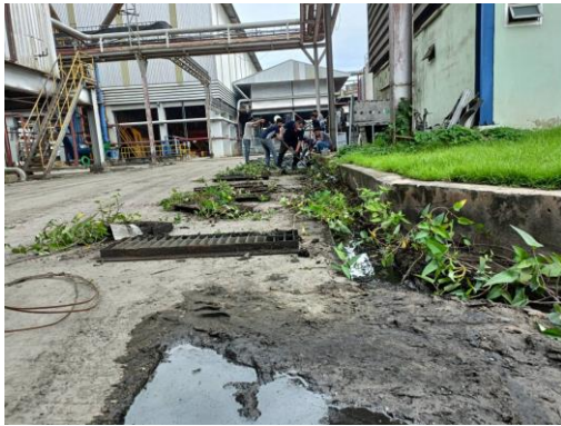
รูปที่ 23 การขุดลอกทำความสะอาดระบบท่อ และรางระบายน้ำ
