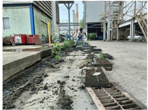
รูปที่ 23 การขุดลอกทำความสะอาดระบบท่อ และรางระบายน้ำ
