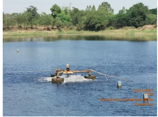
รูปที่ 22 เครื่องเติมอากาศในบ่อพักน้ำทิ้งหลังผ่านการบำบัด (Holding Pond)
