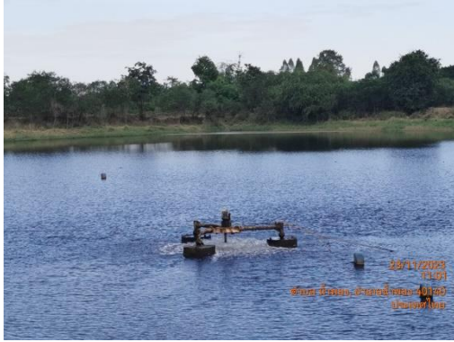
รูปที่ 22 เครื่องเติมอากาศในบ่อพักน้ำทิ้งหลังผ่านการบำบัด (Holding Pond)
