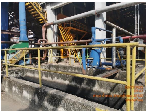
รูปที่ 17 บ่อแยกน้ำมัน (Oil Separator)
