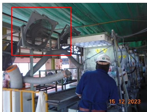
ภาพที่ 2-37 ระบบระบายอากาศและการใช้ลมเย็น
