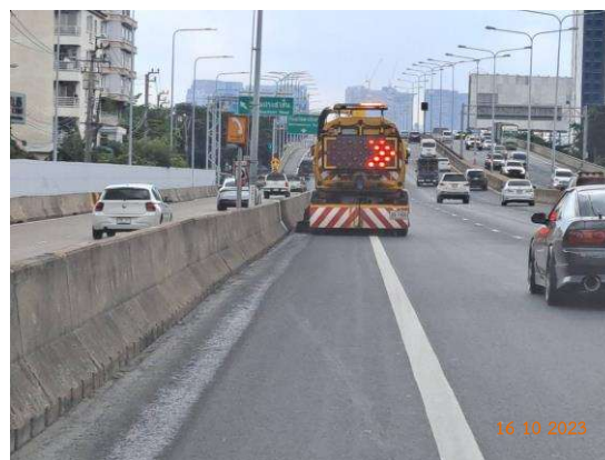
รูปที่ 2-7 การทำความสะอาดพื้นผิวจราจรด้วยรถดูดกวาด
