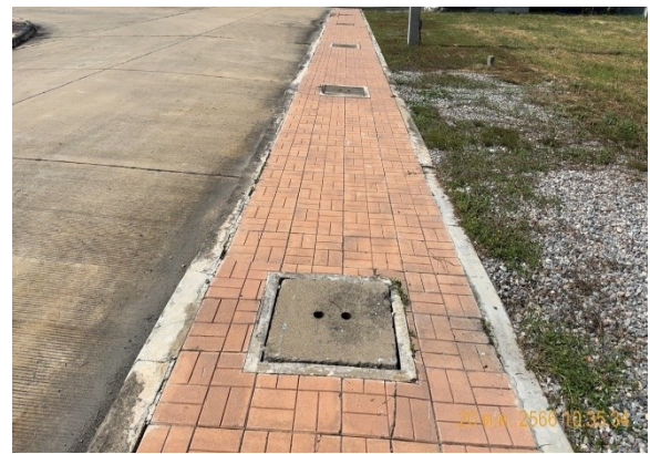
รูปถ่ายที่ 3.2-17 : รางระบายน้ำฝนภายในพื้นที่โครงการ
