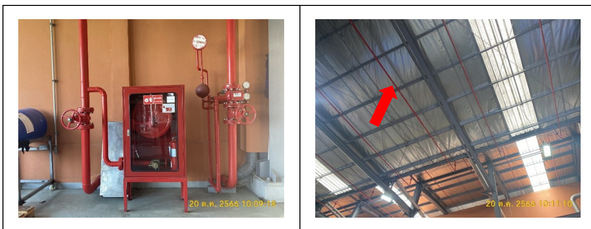
รูปถ่ายที่ 3.2-32 : ท่อน้ำดับเพลิงบริเวณอาคารผลิตและภายในอาคารเก็บสินค้าแอลกอฮอล์
