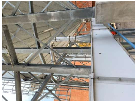
ฝุ่นถูกดูดไล่เสียงผ่านท่อเพื่อเข้าสู่ Dust Collector
