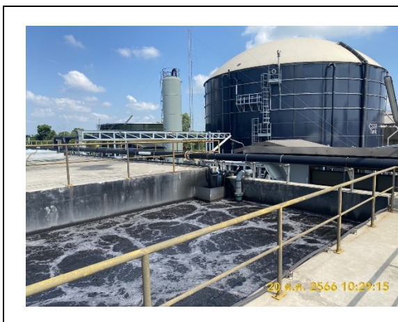
รูปถ่ายที่ 3.2-6 : ระบบบำบัดน้ำเสียของโครงการ
