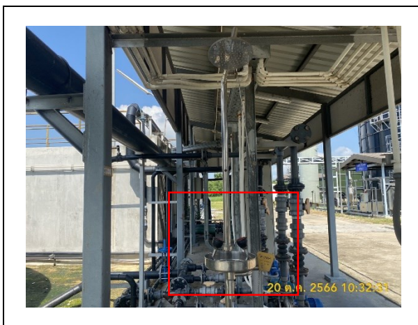
รูปถ่ายที่ 3.2-25 : ฝักบัวฉุกเฉินและอ่างล้างตา
