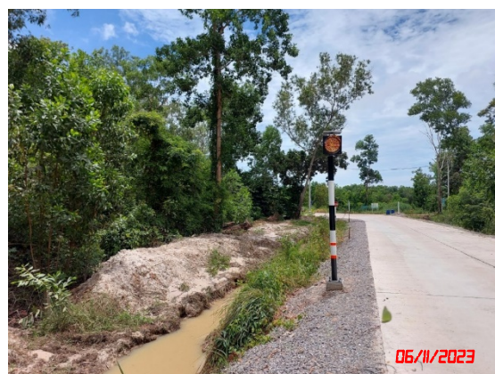
รูปที่ 8 ป้ายเตือนระวังรถบรรทุกเข้า-ออก และสัญญาณไฟกระพริบ
