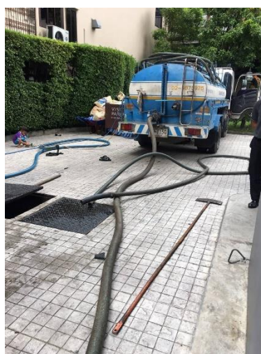
ภาพที่ 2.2-8 การสูบน้ำและตักไขมัน
