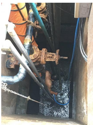
ภาพที่ 2.2-8 การสูบน้ำและตักไขมัน
