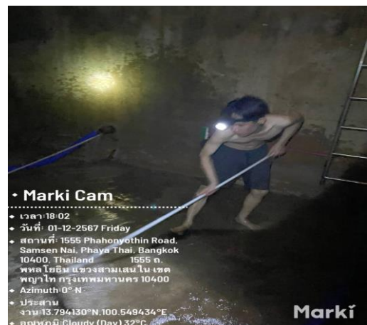
ภาพที่ 2.2-13 ทำความสะอาดถังเก็บน้ำประปา
