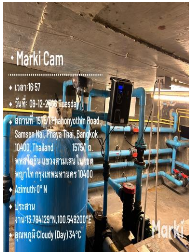
ระบบเครื่องกรองน้ำสระว่ายน้ำ
