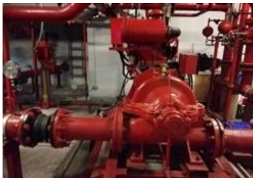
ปั๊ม และถังเก็บน้ำสำรองเพื่อการอุปโภค-บริโภค และเพื่อการดับเพลิงชั้นใต้ดิน
