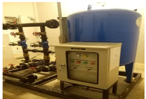
ปั๊ม และถังเก็บน้ำสำรองชั้นดาดฟ้า ภาพที่ 2.2-9 ระบบน้ำใช้โครงการ
