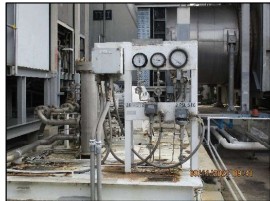
De-NO x Water System HRSG#2
