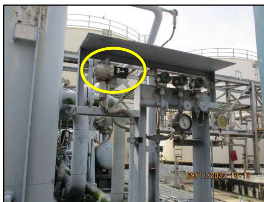
ภาพถ่ายที่ 2.2-25 สายล่อฟ้า สายดิน และ Gas Detector
