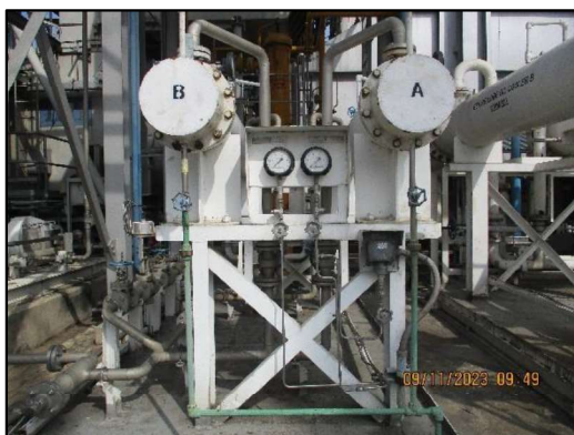
De-NO x Water System HRSG#3
