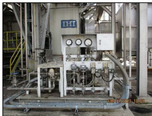
De-NO x Water System HRSG#5
