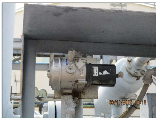
ภาพถ่ายที่ 2.2-25 สายล่อฟ้า สายดิน และ Gas Detector
