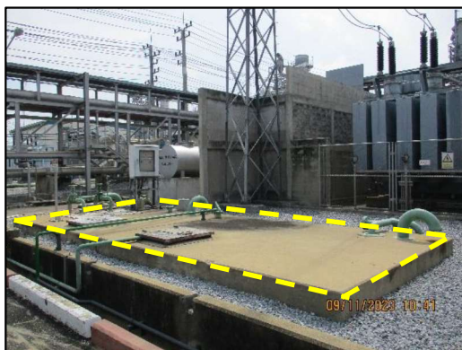
ภาพถ่ายที่ 2.2-11 ถังแยกน้ำและน้ำมัน (Oil Separator)
