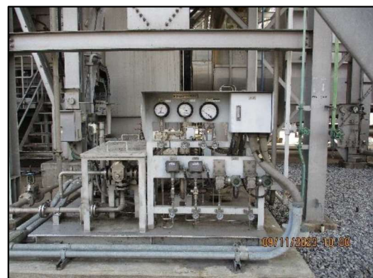
De-NO x Water System HRSG#4
