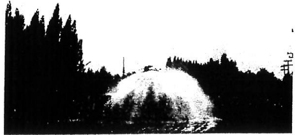
รูปที่ 6 รถบรรทุกน้ำฉีดพรมบนผิวถนนรอบโรงโม่ เพื่อลดฝุ่นละออง
