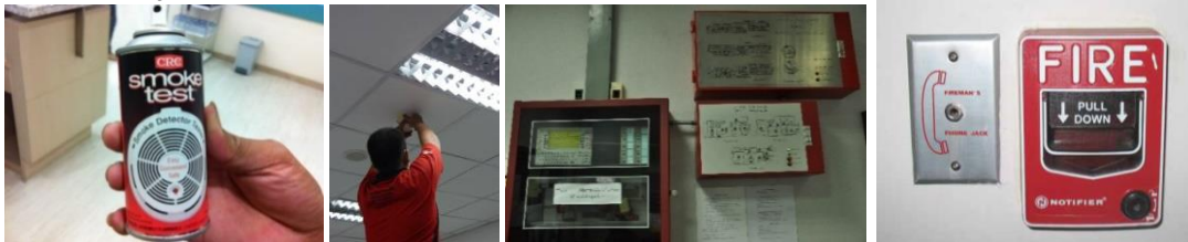
รูปที่ 27 การตรวจสอบสภาพความพร้อมใช้ของระบบสัญญาณแจ้งเหตุเพลิงไหม้
