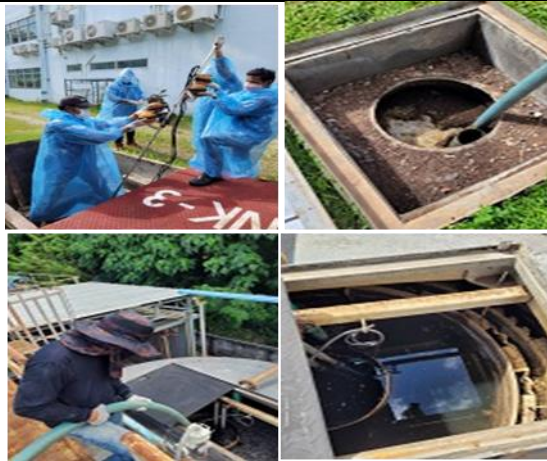
(ภาพที่ 18) การตรวจสอบและกำจัดตะกอนส่วนเกินจากระบบบำบัดน้ำเสีย
