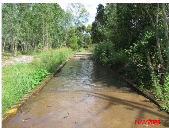
รูปที่ 9 ลานล้างล้อรถบรรทุก
