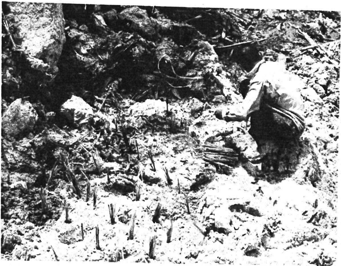
ภาพที่ 2 การปลูกหญ้าแฝกบริเวณคันดินขอบบ่อเหมือง
