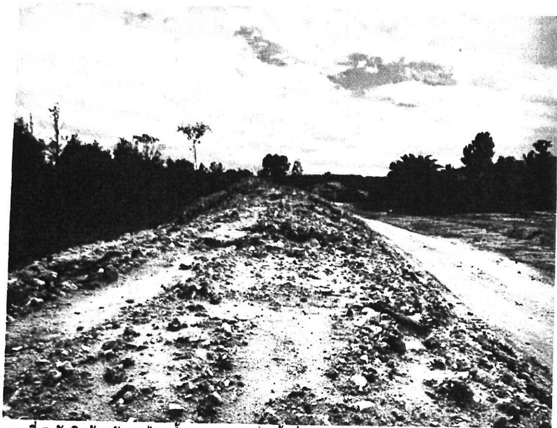
ภาพที่ 5 คันดินป้องกันการไหลน้ำจากคลองสุญเข้าพื้นที่โครงการในช่วงหน้าฝน
