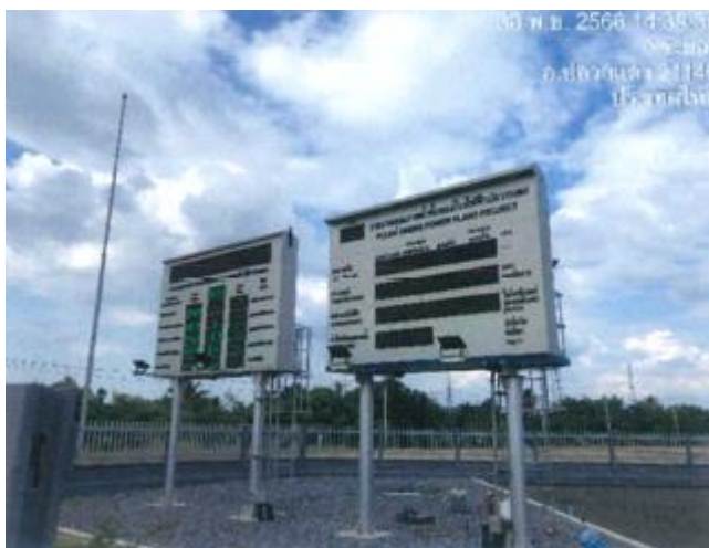
ภาพที่ 2-23 เครื่องตรวจวัดลักษณะสมบัติน้ำทิ้งอัตโนมัติ (Online monitoring)
