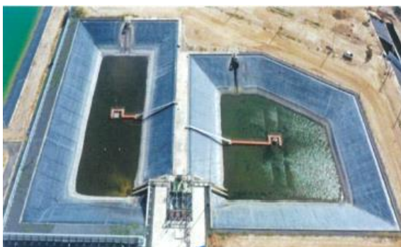
ภาพที่ 2-21 บ่อพักน้ำทิ้ง Cooling Water Blowdown
