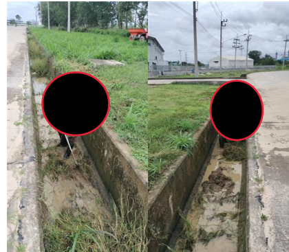
ภาพที่ 2-12 การกำจัดวัชพืชและทำความสะอาดรางระบายน้ำฝนภายในพื้นที่โครงการ
