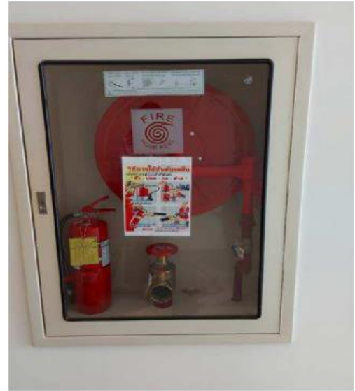
รูปภาพที่ 14 ภาพสายฉีดดับเพลิงและตู้ FHC
