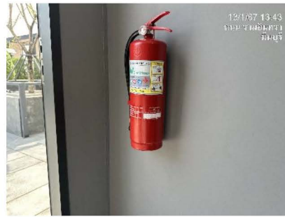
ภาพที่ 2-59 ถังดับเพลิงเคมี บริเวณ ทางเดิน
