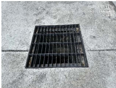
ภาพที่ 2-83 ฝาท่อระบายน้ำเป็นแบบฝาตะแกรงเหล็ก
