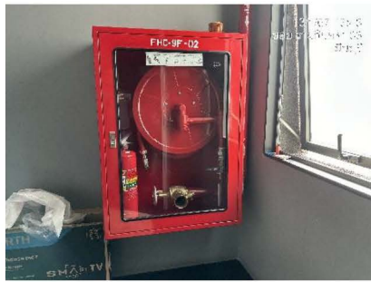
ภาพที่ 2-58 ตู้เก็บสายฉีดน้ำดับเพลิง พร้อมอุปกรณ์
