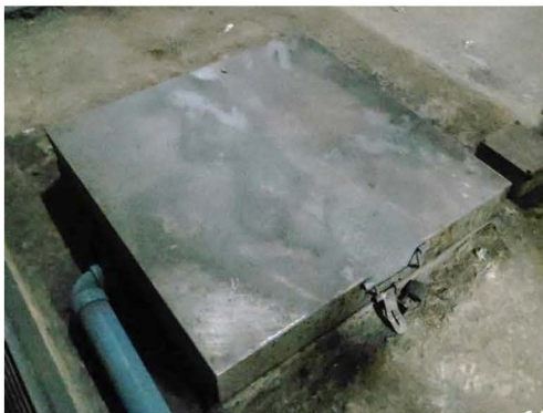
ภาพที่ 2-19 บ่อหน่วงน้ำใต้ดินและท่อรวบรวมน้ำบนดิน
