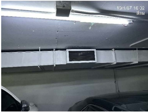
ภาพที่ 2-25 ระบบระบายอากาศออกจากลานจอดรถใต้ดิน
