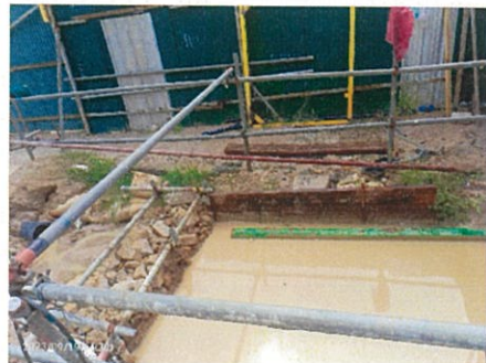
ภาพที่ 2-11 รางระบายน้ำชั่วคราวและบ่อดักตะกอน
