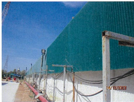
ภาพที่ 2-2 การล้อมรั้วชั่วคราวรอบพื้นที่ก่อสร้าง
