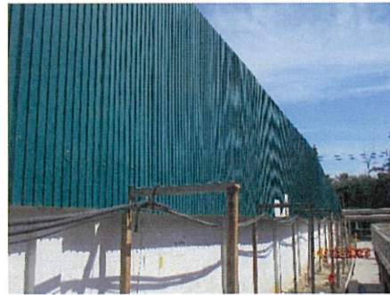
ภาพที่ 2-2 การล้อมรั้วชั่วคราวรอบพื้นที่ก่อสร้าง
