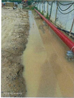
ภาพที่ 2-11 รางระบายน้ำชั่วคราวและบ่อดักตะกอน
