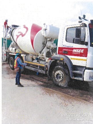
ภาพที่ 2-5 บริเวณล้างล้อรถบรรทุกก่อนออกจากพื้นที่โครงการทุกครั้ง
