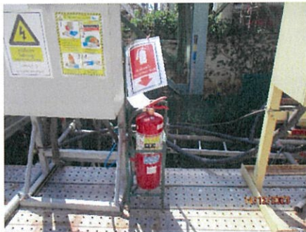
ภาพที่ 2-24 อุปกรณ์ระบบป้องกันและระงับอัคคีภัยและถังดับเพลิง
