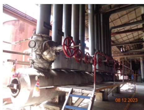
ภาพที่ 2.2-62 วาล์วควบคุม (Control valve) บริเวณกังหันไอน้
