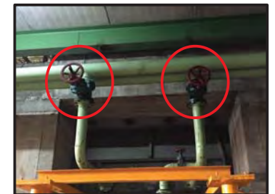
14. เปิดวาล์วน้ำระบายความร้อนของเครื่องเทอร์โบไนน์
