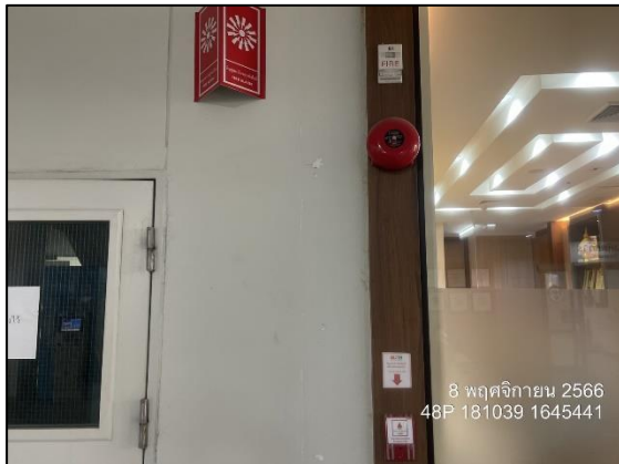
รูปที่ 2.2-33 ระบบสัญญาณเตือนเพลิงไหม้โดยมือ กริ่งสัญญาณเตือนไฟไหม้
