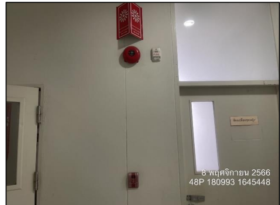
รูปที่ 2.2-33 ระบบสัญญาณเตือนเพลิงไหม้โดยมือ กริ่งสัญญาณเตือนไฟไหม้
