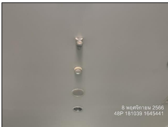
รูปที่ 2.2-33 ระบบสัญญาณเตือนเพลิงไหม้โดยมือ กริ่งสัญญาณเตือนไฟไหม้
