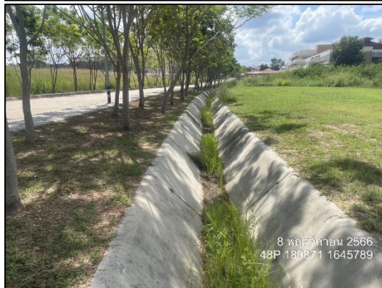
รูปที่ 2.2-22 รางระบายน้ำฝนของโครงการ
