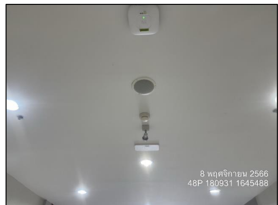
รูปที่ 2.2-33 ระบบสัญญาณเตือนเพลิงไหม้โดยมือ กริ่งสัญญาณเตือนไฟไหม้
