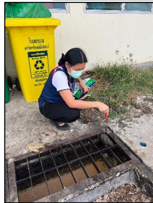
รูปที่ 2.2-23 บ่อดักไขมันหลังอาคารโรงอาหารและการทำความสะอาดบ่อดักไขมัน
