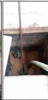
รูปที่ 2.2-23 บ่อดักไขมันหลังอาคารโรงอาหารและการทำความสะอาดบ่อดักไขมัน
