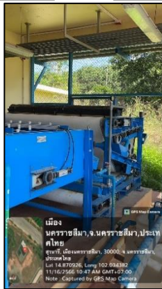
รูปที่ 2.2-21 ตะแกรงดักขยะของระบบบำบัดน้ำเสีย
