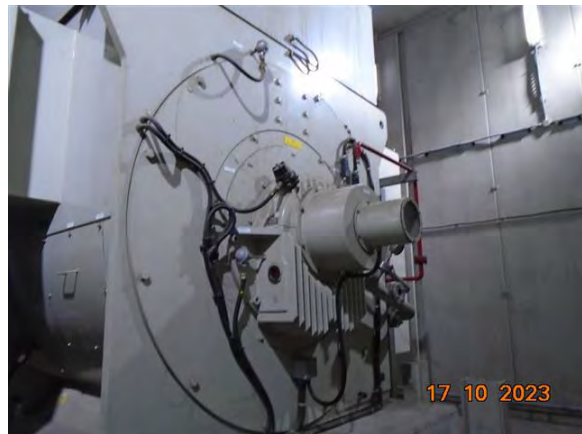
ภาพที่ 2.2-7 เครื่องกังหันไอน้ำ (อยู่ภายในอาคารที่มีวัสดุดูดซับเสียง)
