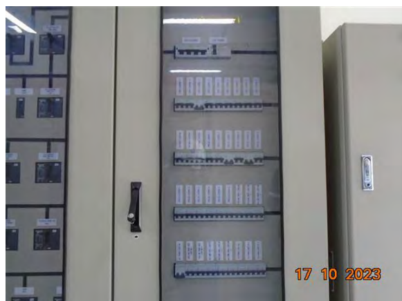
ภาพที่ 2.2-30 ระบบป้องกันไฟฟ้าช็อต
