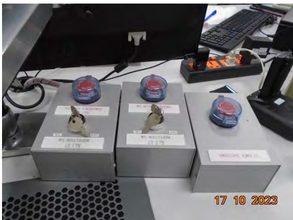
ภาพที่ 2.2-38 Emergency Switch
