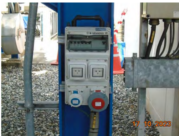
ภาพที่ 2.2-29 ระบบป้องกันไฟฟ้ารั่ว
