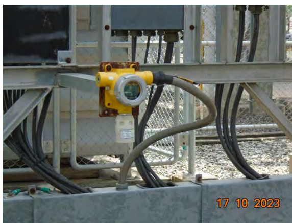
ภาพที่ 2.2-31 ระบบป้องกันการรั่วซึมของก๊าซ (Gas Detector)
