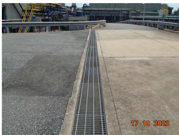
ภาพที่ 2.2-24 รางระบายน้ำฝนรอบโรงไฟฟ้า
