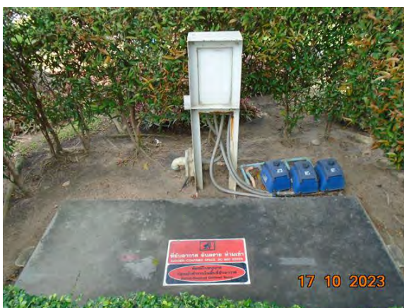
ภาพที่ 2.2-25 ระบบบำบัดน้ำเสียสำเร็จรูป (Septic Tank)
