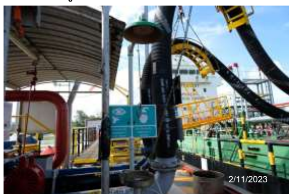
รูปที่ 2-14 จุดอาบน้ำและล้างตา กรณีฉุกเฉิน บนท่าเทียบเรือ
