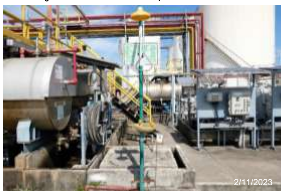
รูปที่ 2-28 ที่อาบน้ำและล้างตาในกรณีฉุกเฉิน
