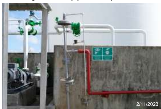
รูปที่ 2-28 ที่อาบน้ำและล้างตาในกรณีฉุกเฉิน
