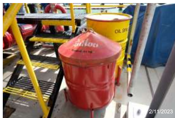
รูปที่ 2-4 ภาชนะรองรับน้ำมัน และถังบรรจุน้ำมันเพื่อสูบน้ำมัน
