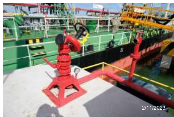
รูปที่ 2-19 อุปกรณ์และระบบดับเพลิงบนท่าเทียบเรือ
