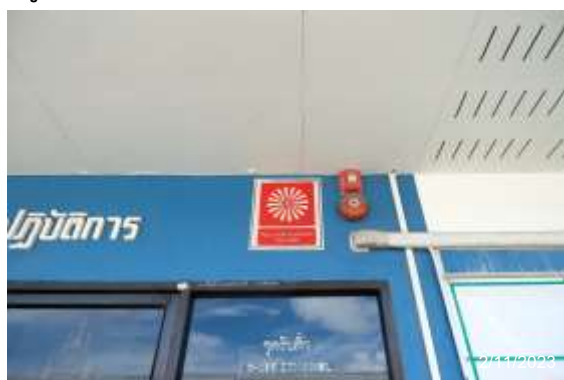
รูปที่ 2-27 สัญญาณแจ้งเหตุไฟไหม้
