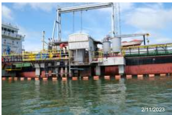
รูปที่ 2-5 (ต่อ) ที่กั้นเพื่อป้องกันการแพร่กระจายน้ำมันในกรณีเกิดการรั่วไหลลงทะเล
