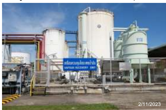
รูปที่ 2-26 เครื่องควบคุมไอระเหยน้ำมัน
