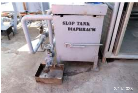
รูปที่ 2-4 ภาชนะรองรับน้ำมัน และถังบรรจุน้ำมันเพื่อสูบน้ำมัน
