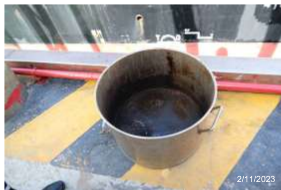
รูปที่ 2-3 บ่อ API และคันทันเพื่อตักน้ำมันและภาชนะรองรับน้ำมัน บนท่าเทียบเรือ
