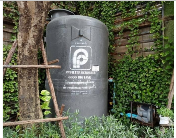
รูปที่ 2-12 ระบบบำบัดละอองน้ำเสีย
