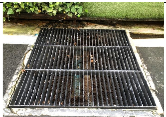
รูปที่ 2-28 ตะแกรงดักขยะ
