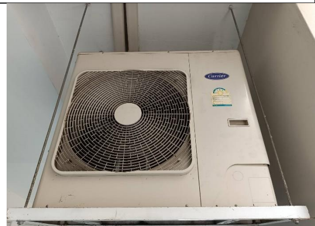
รูปที่ 2-22 Air Compressor
