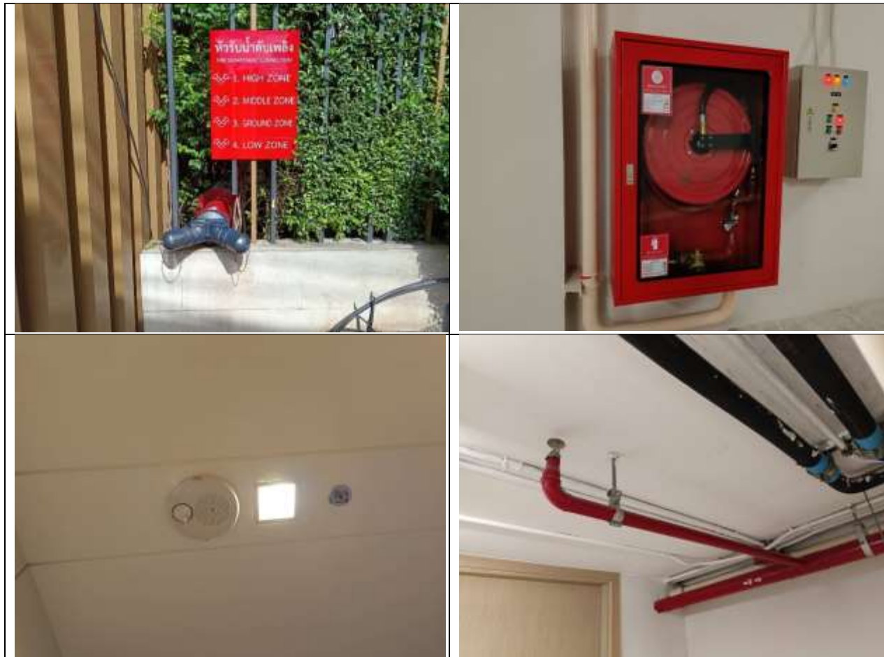
รูปที่ 2-29 อุปกรณ์ป้องกันอัคคีภัยและอุปกรณ์ดับเพลิง
