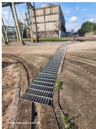
ภาพที่ 2-11 วางระบายน้ำฝนในพื้นที่โครงการ
