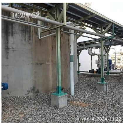
ภาพที่ 2-7 การเดินท่อและติดตั้งปั๊มเพื่อนำน้ำทิ้งจากกระบวนการผลิตมาใช้ใหม่
