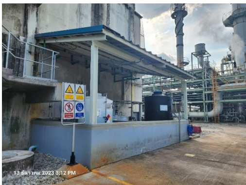
ภาพที่ 2-26 คันคอนกรีตป้องกันการทกรั่วไหลของสารเคมี
