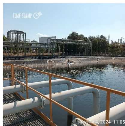
ภาพที่ 2-7 การเดินท่อและติดตั้งปั๊มเพื่อนำน้ำทิ้งจากกระบวนการผลิตมาใช้ใหม่
