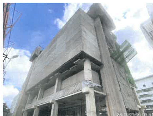
รูปที่ 2-21 แสดงการติดตั้งผ้าใบกันฝุ่น (Mesh Sheet) ปิดคลุมด้านนอกโดยรอบตัวอาคารที่กำลังก่อสร้าง
