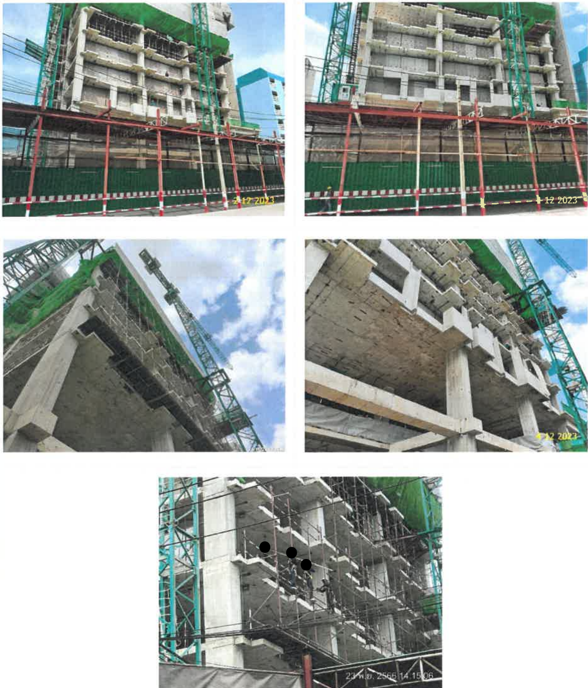
รูปที่ 2-28 แสดงการใช้ผนังคอนกรีตสำเร็จรูป (Precast Concrete)
