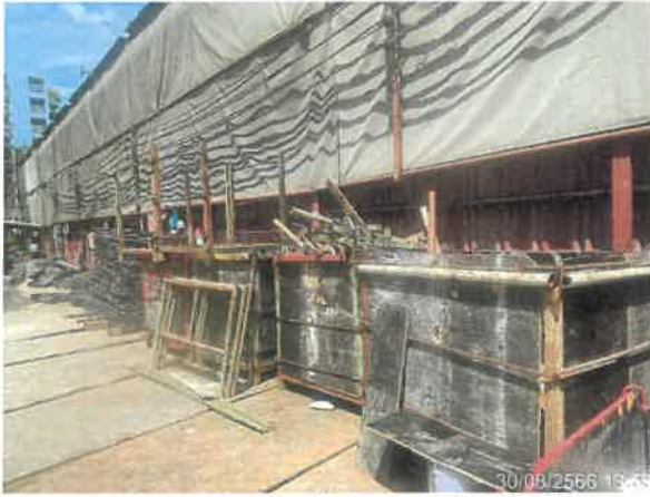
รูปที่ 2-18 แสดงกล่องไม้ที่ปิดล้อมทั้ง 4 ด้าน ไว้สำหรับเก็บเศษวัสดุก่อสร้าง
