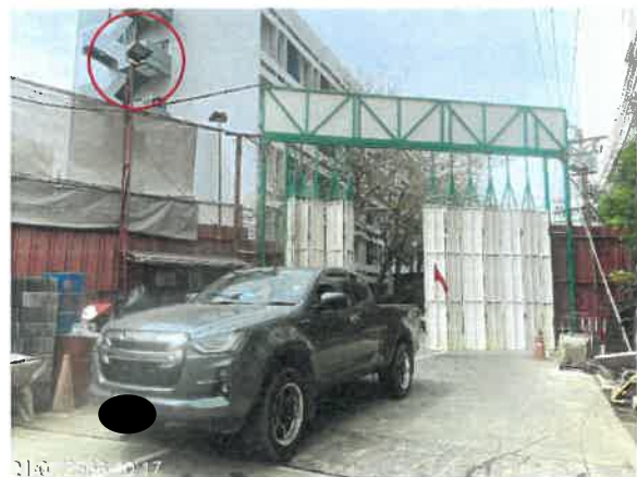
รูปที่ 2-9 แสดงการติดตั้งไฟสปอตไลท์ไว้ตามรั้วเมทัลชีท (Metal Sheet) ภายในพื้นที่ก่อสร้าง
