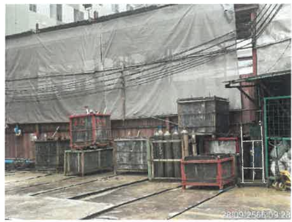
รูปที่ 2-18 แสดงกล่องไม้ที่ปิดล้อมทั้ง 4 ด้าน ไว้สำหรับเก็บเศษวัสดุก่อสร้าง
