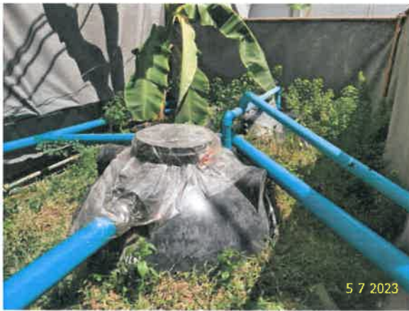
รูปที่ 2-34 แสดงระบบบำบัดน้ำเสียสำเร็จรูป
