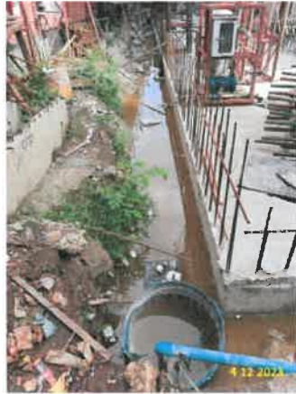
รูปที่ 2-5 แสดงรางระบายน้ำชั่วคราว พร้อมทั้งติดตั้งท่อระบายน้ำ
