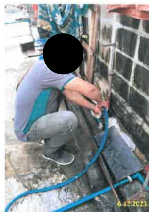
รูปที่ 2-44 แสดงเจ้าหน้าที่ตรวจสอบจุดรั่วซึมของระบบน้ำประปาทั้งในพื้นที่ก่อสร้าง และบ้านพักคนงาน
