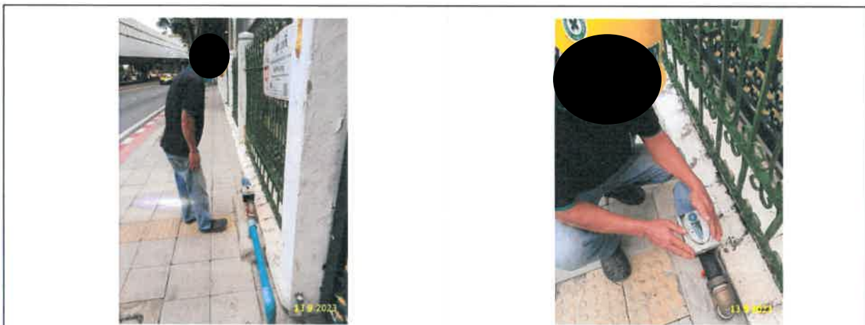
รูปที่ 2-40 แสดงติดตั้งมิเตอร์รับน้ำและระบบท่อประปาเชื่อมต่อกับท่อประปาของสำนักงานประปานครหลวง
