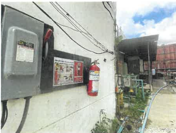
รูปที่ 2-74 แสดงถังดับเพลิงชนิดผงเคมีแห้ง พร้อมป้ายแนะนำการใช้งาน
