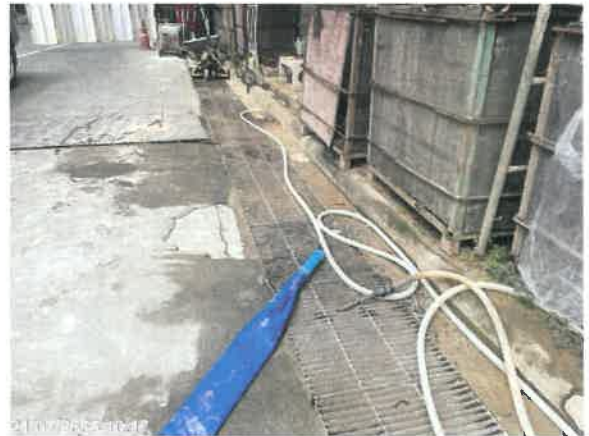
รูปที่ 2-5 แสดงรางระบายน้ำชั่วคราว พร้อมทั้งติดตั้งท่อระบายน้ำ
