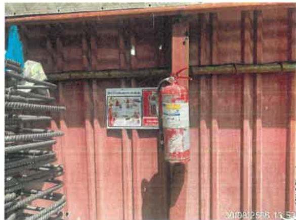
รูปที่ 2-74 แสดงถังดับเพลิงชนิดผงเคมีแห้ง พร้อมป้ายแนะนำการใช้งาน
