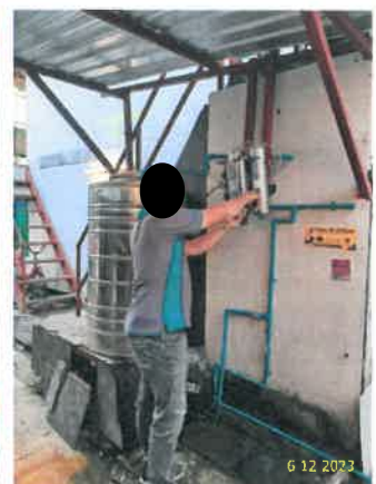
รูปที่ 2-44 แสดงเจ้าหน้าที่ตรวจสอบจุดรั่วซึมของระบบน้ำประปาทั้งในพื้นที่ก่อสร้าง และบ้านพักคนงาน
