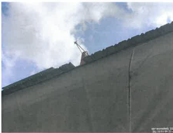
รูปที่ 2-16 แสดงการติดตั้งสปริงเกอร์พ่นน้ำไว้บริเวณโดยรอบรั้วโครงการ
