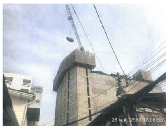
รูปที่ 2-21 แสดงการติดตั้งผ้าใบกันฝุ่น (Mesh Sheet) ปิดคลุมด้านนอกโดยรอบตัวอาคารที่กำลังก่อสร้าง
