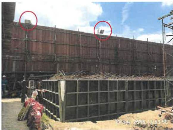
รูปที่ 2-9 แสดงการติดตั้งไฟสปอตไลท์ไว้ตามรั้วเมทัลชีท (Metal Sheet) ภายในพื้นที่ก่อสร้าง
