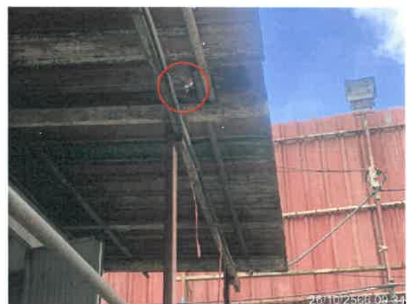
รูปที่ 2-16 แสดงการติดตั้งสปริงเกอร์พ่นน้ำไว้บริเวณโดยรอบรั้วโครงการ
