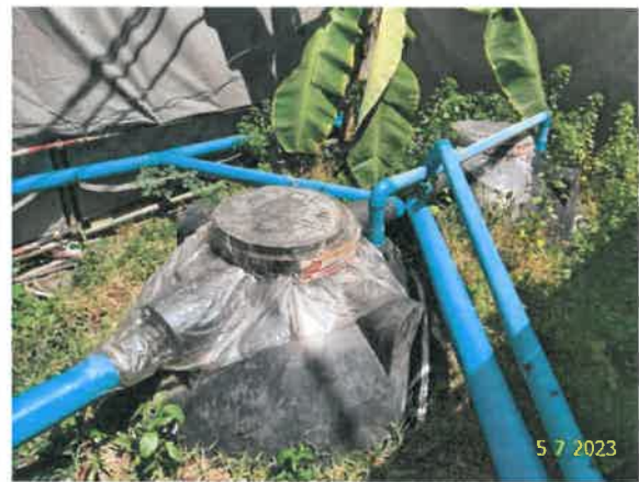
รูปที่ 2-34 แสดงระบบบำบัดน้ำเสียสำเร็จรูป
