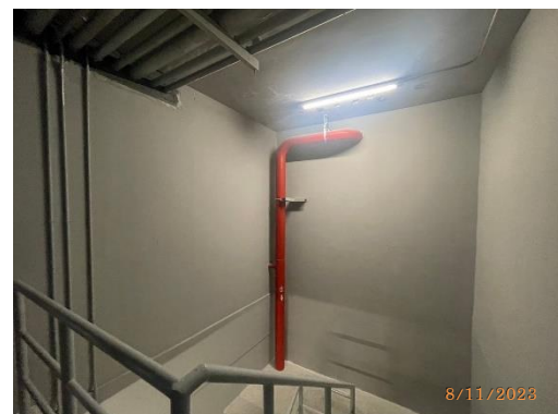
รูปที่ 49 ระบบท่อยืน (Fire Stand Pipe)
