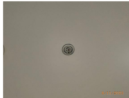
รูปที่ 42 หัวฉีดน้ำอัตโนมัติ
