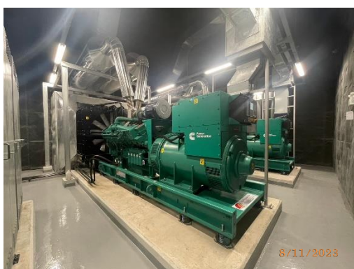
รูปที่ 33 เครื่องกำเนิดไฟฟ้าฉุกเฉิน
