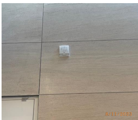
รูปที่ 43 ลำโพงแจ้งสัญญาณเตือนภัย (Fire Alarm Speaker)
