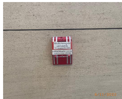
รูปที่ 44 เครื่องแจ้งเหตุโดยใช้มือดึง (Manual Pull Station)
