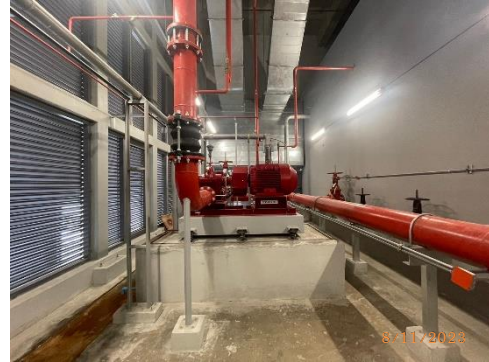
รูปที่ 40 เครื่องสูบน้ำดับเพลิง (Fire pump)
