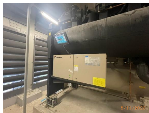
รูปที่ 34 ติดตั้งระบบчилเลอร์ เพื่อประหยัดพลังงาน
