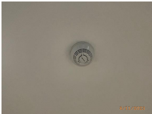
รูปที่ 41 เครื่องตรวจจับควัน (Smoke Detector)
