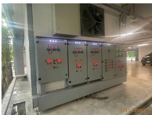
รูปที่ 21 ระบบมอเตอร์ไฟฟ้าสำหรับระบบบำบัดน้ำเสีย
