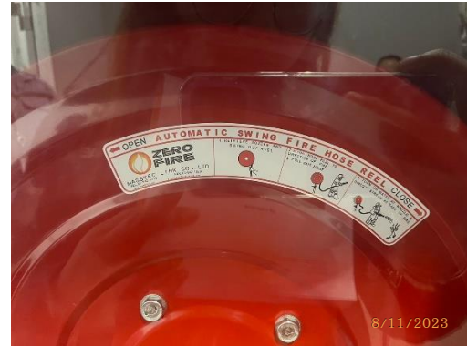
รูปที่ 50 ตู้เก็บสายฉีดน้ำดับเพลิง และป้ายแนะนำการใช้อุปกรณ์
