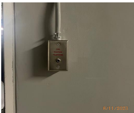
รูปที่ 48 โทรศัพท์แจ้งเหตุเพลิงไหม้ (Fire Man Telephone Outet)
