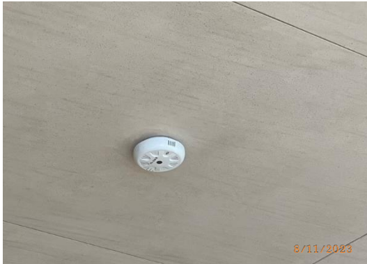
รูปที่ 45 เครื่องตรวจจับความร้อน (Heat Detector)
