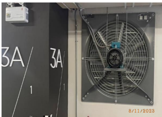
รูปที่ 19 พัดลมระบายอากาศ บริเวณชั้นใต้ดิน
