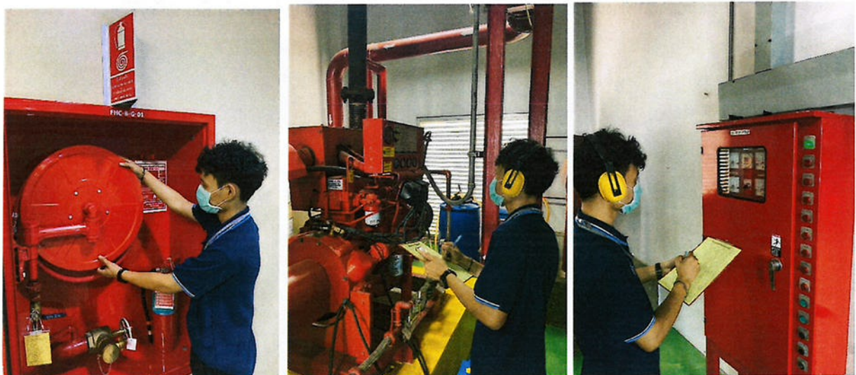
รูปที่ 2-41 การตรวจสอบดูแลรักษาอุปกรณ์ป้องกัน/เตือนภัยอัคคีภัย
