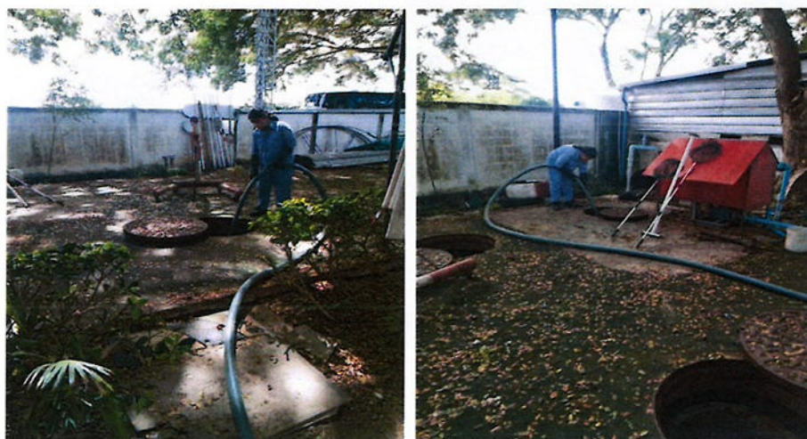
รูปที่ 2-8 เทศบาลตำบลเชิงเนินเข้ามาสูบตะกอนระบบบำบัดน้ำเสีย
