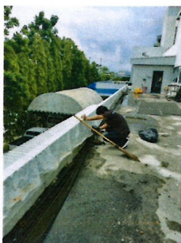
รูปที่ 2-17 ฝ่ายช่างทำความสะอาดท่อบายน้ำ
