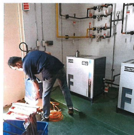
รูปที่ 2-44 การตรวจสอบดูแลระบบออกซิเจนเหลว 1 ครั้ง/ปี และระบบแก๊สทางการแพทย์
