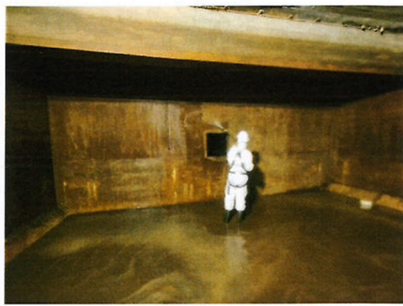
รูปที่ 2-20 การล้างทำความสะอาดบ่อพักน้ำ
