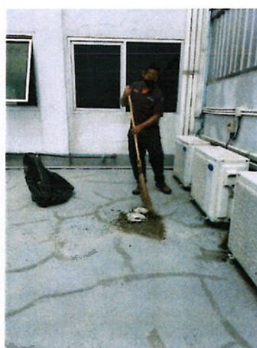
รูปที่ 2-17 ฝ่ายช่างทำความสะอาดท่อบายน้ำ
