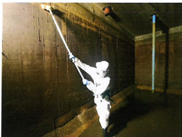
รูปที่ 2-20 การล้างทำความสะอาดบ่อพักน้ำ
