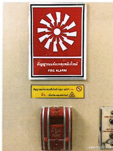
ชุดกดแจ้งเหตุแบบใช้มือดึง Manual Station
