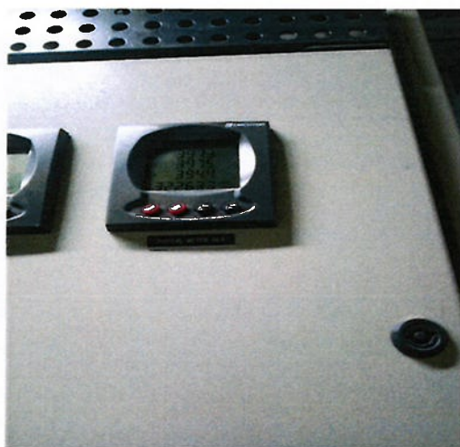
รูปที่ 2-21 มิเตอร์ไฟฟ้าสำหรับระบบบำบัดน้ำเสียของโครงการ
